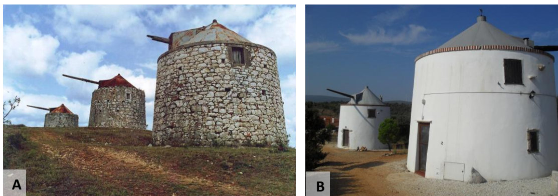
Foto 35 – Moinhos da Pena: antes (A) e depois de recuperados (B - 2013)
