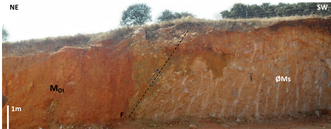
Foto 8 - Contacto por falha inversa dos Arenitos da Ota (M Ot ), com os Arenitos de Monsanto (ØMs), visível no topo da escarpa dos Arrifes junto aos moinhos do Alto da Pena (Assentiz).
