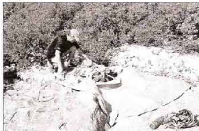
Ventilation du STR 0077
